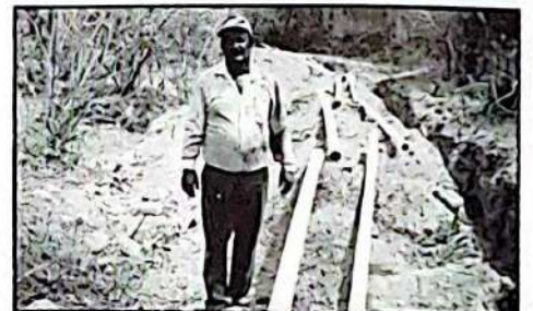
Hermano Enob Isai Morales Arriaza, cuando se está enterrando la tubería para conducción de agua del pozo a las piscinas.
