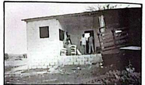
Construcción de casa para guardián en el Campamento de Retiro Espiritual
